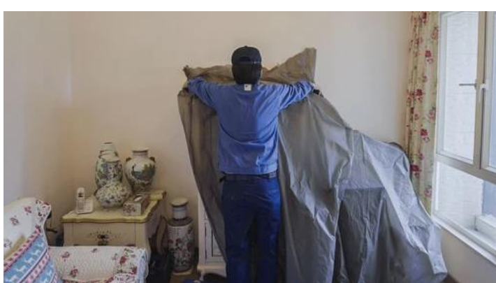
2. 保護冷氣周圍物件 (使用一次性膠布 非重複使用)
