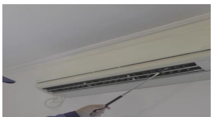
1. 檢查冷氣機運作情況
