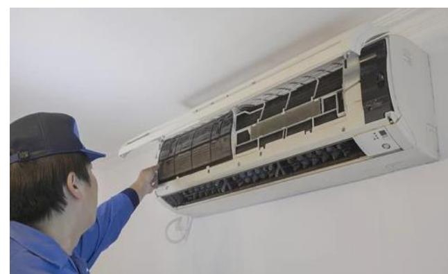
3. 關閉機組電源及拆除冷氣部件
