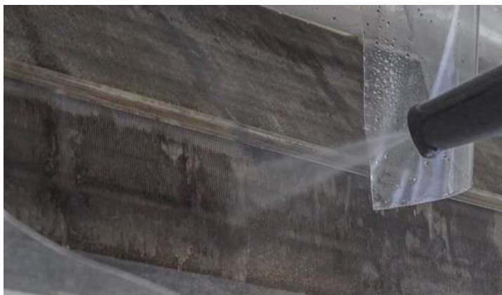
5. 開始高壓水槍沖洗 (清洗熱交換器、風扇滾筒、水盤、通去水位)
