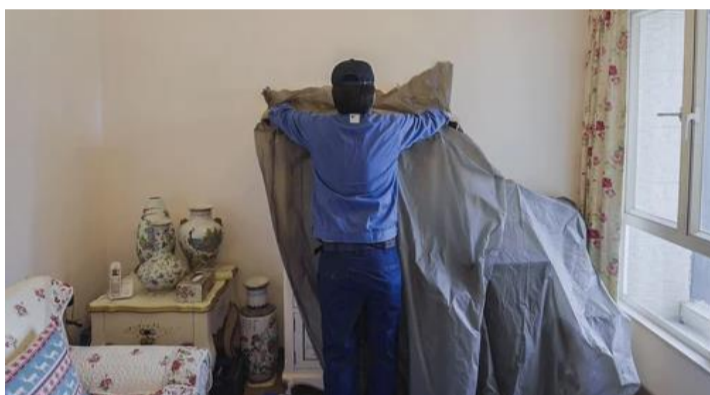
2. 保護冷氣周圍物件 (使用一次性膠布 非重複使用)
