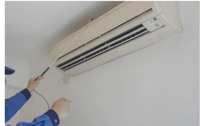
12. 再次檢查運作情況及量度溫度
