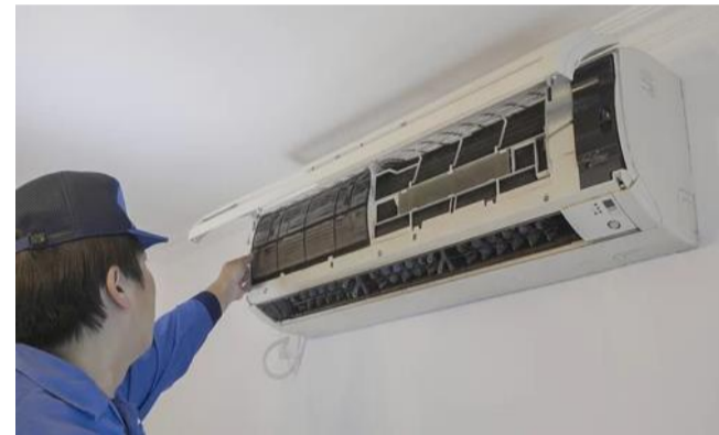
3. 關閉機組電源及拆除冷氣部件
